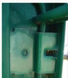
fig. 3 : Clips de fixation feuillure
